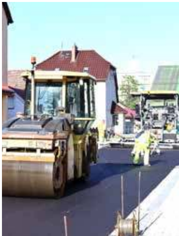
Trwa asfaltowanie odcinka drogi na ul. Żeromskiego od strony cmentarza
