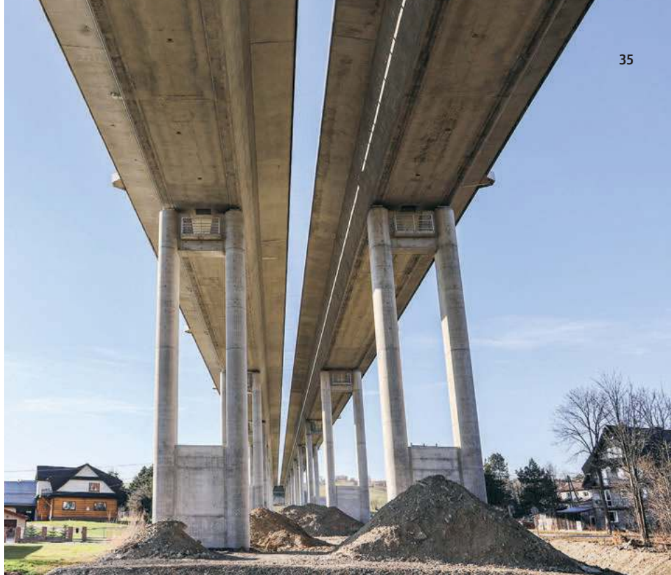
Domy pod estakadą w ciągu drogi krajowej nr 47 we wsi Lasek. 3 kwietnia 2025 r.
