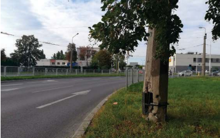
Zniszczone słupy trakcji trolejbusowej przy ul. Gospodarczej zostaną wymienione
