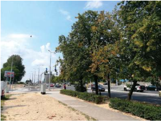
Mimo montażu nowego oświetlenia przy skrzyżowaniu ul. Chodźki z al. Smorawińskiego okazał się on niewystarczający, co skutkuje tonieniem chodnika po zmroku.
