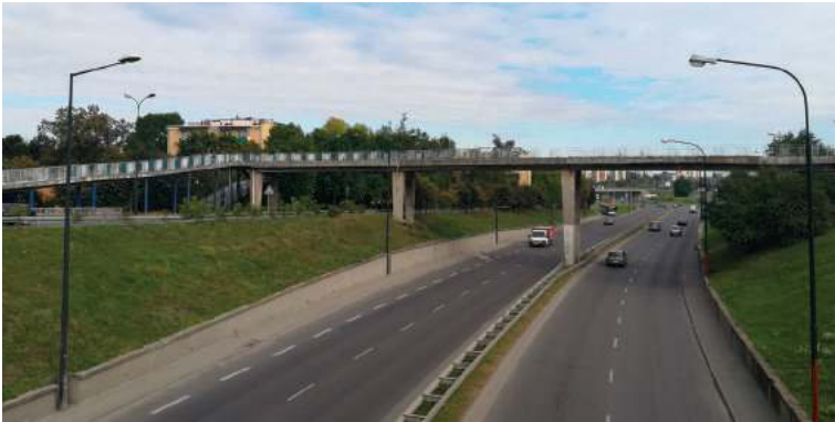
Kładka nad al. Tysiąclecia czeka na rozbiórkę
