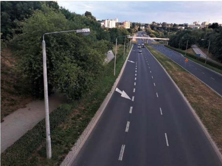
– Uliczne latarnie, które są w złym stanie technicznym zostaną wymienione – zapewnia PGE Dystrybucja
