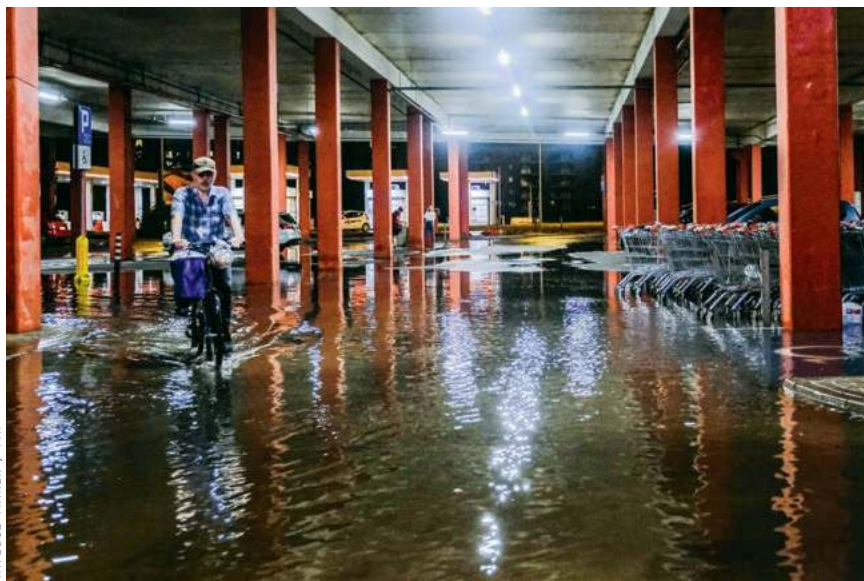
Zalania po gwałtownej burzy. Centrum handlowe w Warszawie, sierpień 2020 r.
