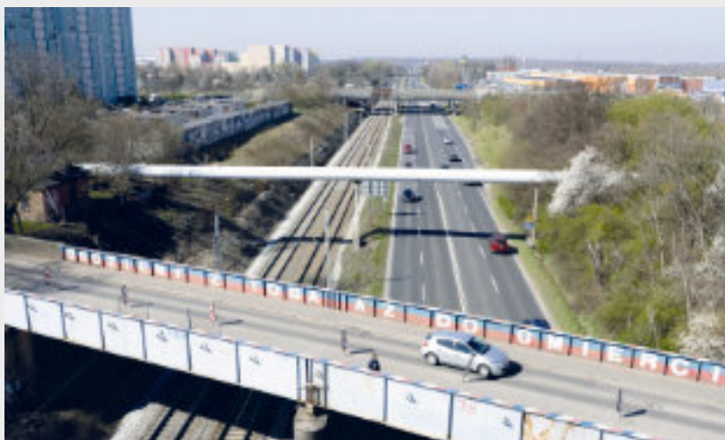
▶ Objęty przebudową wiadukt Fot. UM Zabrze
