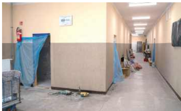
Skala przedsięwzięcia pozwala przypuszczać, że efekty będą odczuwalne nie tylko w komforcie codziennego użytkowania, lecz także w estetyce i standardzie całego obiektu
