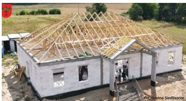
Budowa obiektu przebiega bardzo sprawnie
