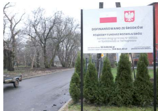
Ulica Spółdzielcza w Tarnogrodzie już po remoncie
