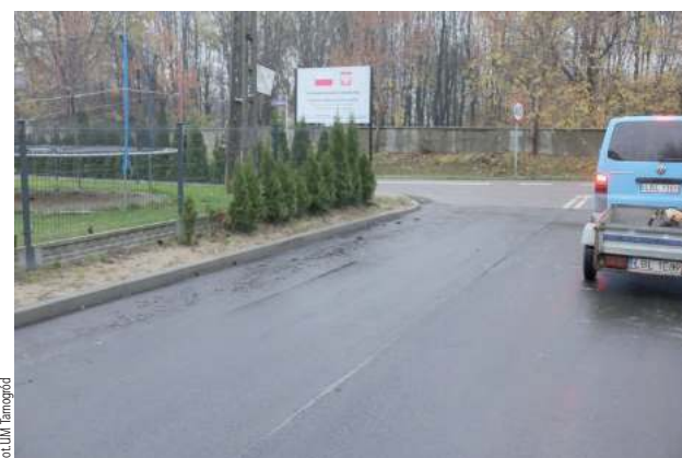
Ulica Spółdzielcza w Tarnogrodzie już po remoncie
