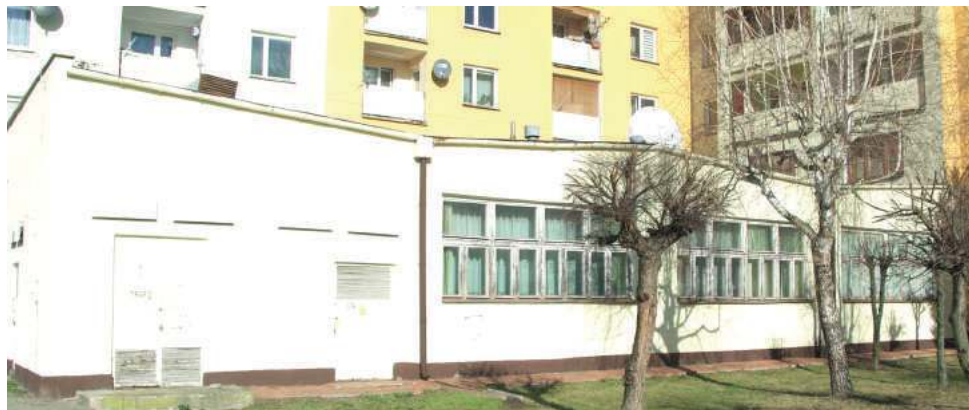
W pomieszczeniach po Osiedlowym Domu Kultury przy ul. 11 Listopada 62 powstanie Centrum Spotkań Międzypokoleniowych oraz centrum miejskiego monitoringu
