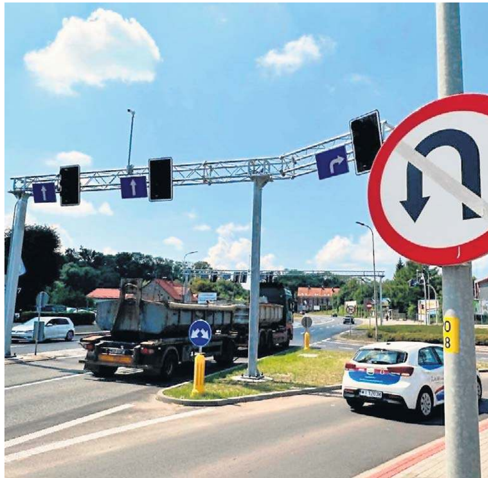
Skrzyżowanie al. Podwale z ul. Wieniawskiego zostało przebudowane
