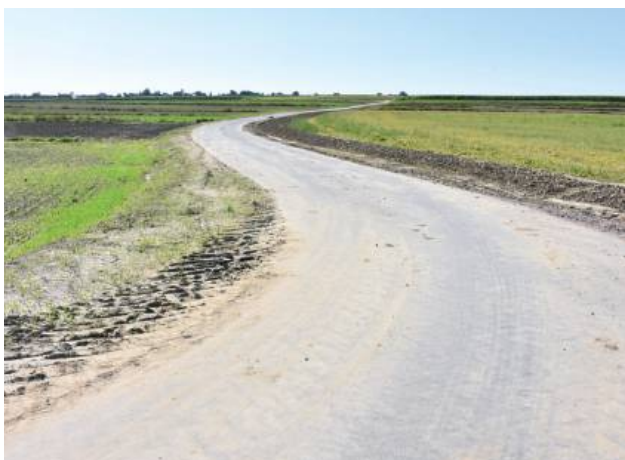
Droga łącząca Czernięcin Główny i Żabno Kolonię wykonana ze środków Nowego Ładu.
