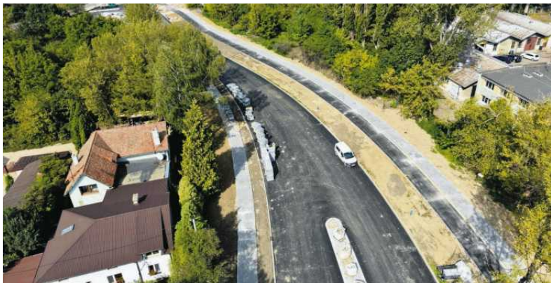
• Nowy odcinek ulicy Białoleckiej, od Węzła Łabiszyńskiego na Trasie Toruńskiej (S8) do ul. Stębarskiej FOT. MATERIAŁY INWESTORA
