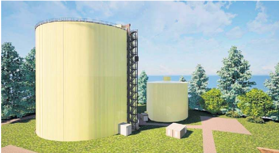
Zakres prac obejmuje budowę konstrukcji silosu o pojemności ponad 60 tys. ton, a także kompletny system załadunku i rozładunku tego obiektu
