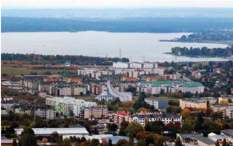
Zalew Zemborzycki powstał dzięki pracom społecznym lublinian w latach 70-tych XX wieku. Zaangażowanych było około 40 tysięcy lublinian, którzy uczestniczyli w pracach budowlanych. Zalew powstał na podmokłych, torfowych łąkach. Zbiornik ma powierzchnię 280 ha i 12 kilometrów linii brzegowej.
