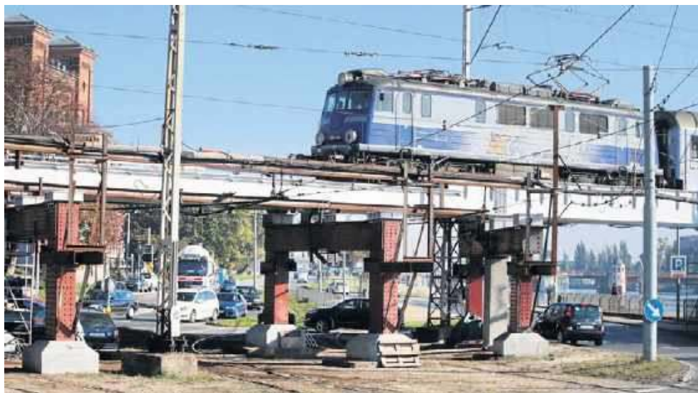
Pociągi kursują już po wyremontowanej części wiaduktu kolejowego nad ulicą Kolumba. Zakończenie prac planowane jest do końca 2021 roku
