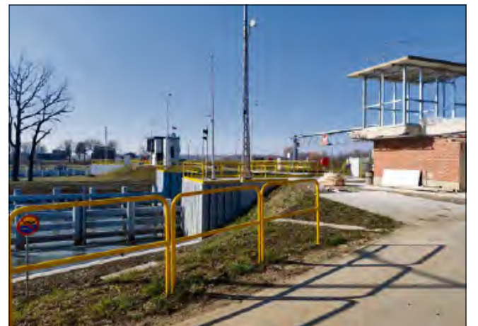
Po modernizacji śluza w Krapkowicach jest jednym z najnowocześniejszych tego typu obiektów na Odrze.
