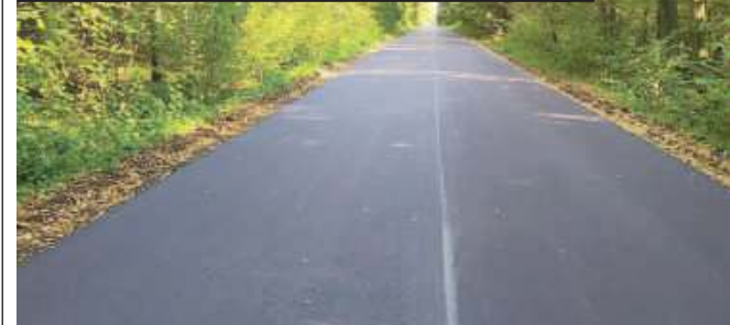
Długość wyremontowanego odcinka drogi nr 1205L to 2,8 km do końca lasu. Wkład własny gminy Kąkolewnica to 50 proc., czyli 430 000,00 zł. W 2020 r. gmina wykonała wspólnie z Powiatem Radzyńskim remont na odcinku 1,5 km w kierunku Lipniaki za kwotę 263 998,00 zł i modernizację drogi Lipniaki - Główne o dł. 800 m za kwotę 40 000,00 zł. - Udało nam się wspólnie wyremontować najgorszą drogę na terenie gminy, w sumie 5,1 km za kwotę 693 998 zł - skomentowała wójt gm. Kąkolewnica Anna Mróz
