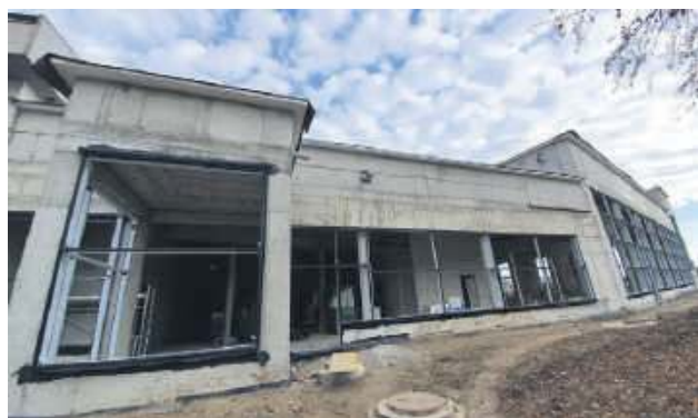
Zakończenie budowy krytej pływalni w Hrubieszowie zaplanowano na marzec 2022 r.
