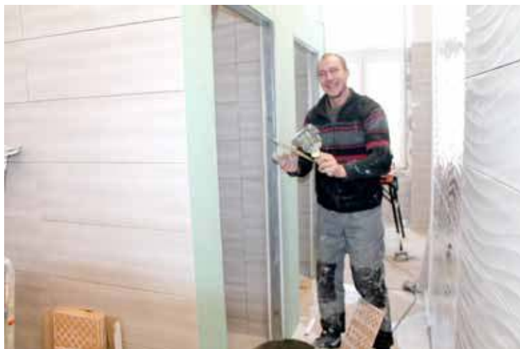
W trakcie remontu toalet męskich w DKK. Wkrótce będą one tak samo odnowione jak toalety damskie
