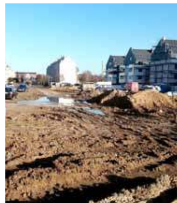
Ruszyła budowa drogi łączącej ulicę Powstańców Warszawy z ulicą Broniewskiego.
