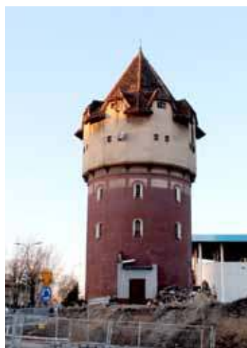
PKP PLK uspokaja, że z przeprowadzonych pomiarów nie wynika by wieża uległa nachyleniu
