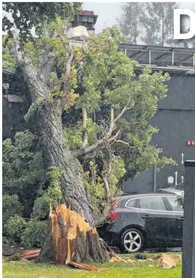
Drzewo uszkodziło budynek w centrum Tarnowskich Gór
