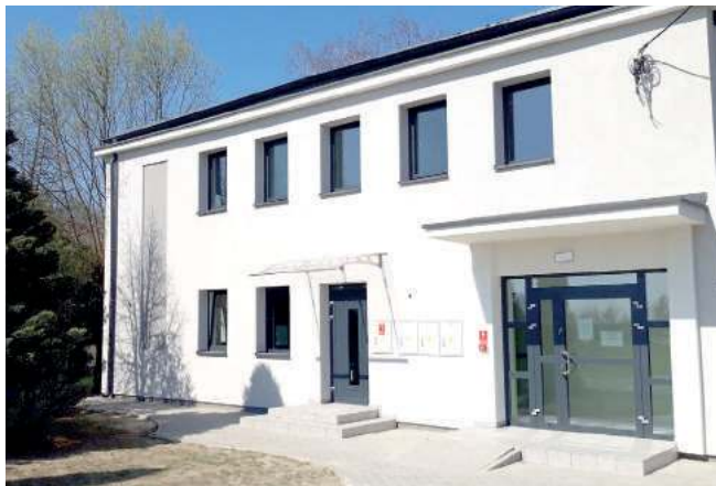
W Wandowie jeszcze kilka lat temu budynek POZ nie przypominał gminnego ośrodka zdrowia. Przychodnia niszczała i wymagała gruntownej przebudowy
