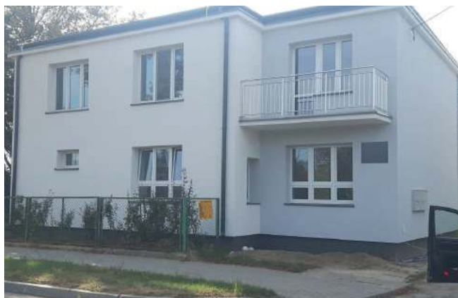
Jedlanka. W dwupiętrowym budynku powstał m.in. gabinet lekarski, zabiegowy, gabinet EKG i recepcja
