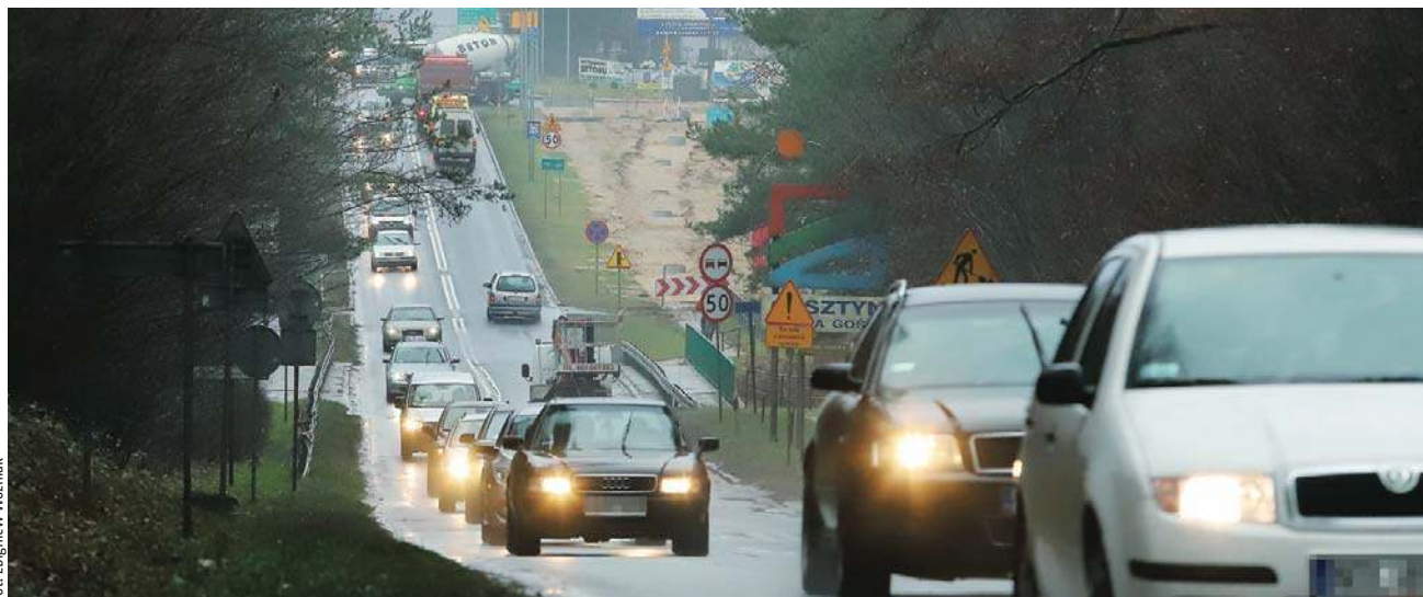
Pod hasłem północnej obwodnicy kryją się: budowa północnej obwodnicy Olsztyna, obwodnica Dywit oraz przebudowa drogi 51 przez Las Miejski (od mostu na Wadąg)
