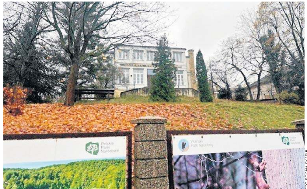
Muzeum w Międzyzdrojach zostanie gruntownie przebudowane, a także znacząco rozbudowane. Powstaną nowe przestrzenie służące edukacji
