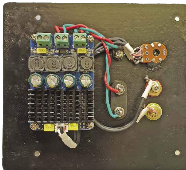
Oto finalna płytkę wzmacniacza, gotowa do zamontowania w jednej z obudów (jest to wzmacniacz stereo, więc wystarczy tylko jeden). Kable łączą się z końcówkami wyjściowymi do drugiej obudowy. To zdjęcie porównaj ze schematem montażowym powyżej (rysunek 16).
