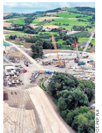
Maszyny TBM już pod Tymbarkiem
