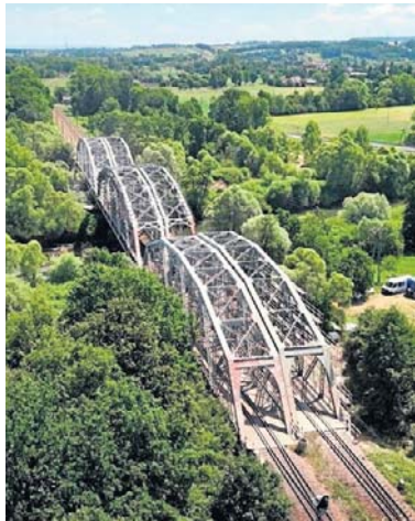
Trwa kolejny etap modernizacji linii 94
