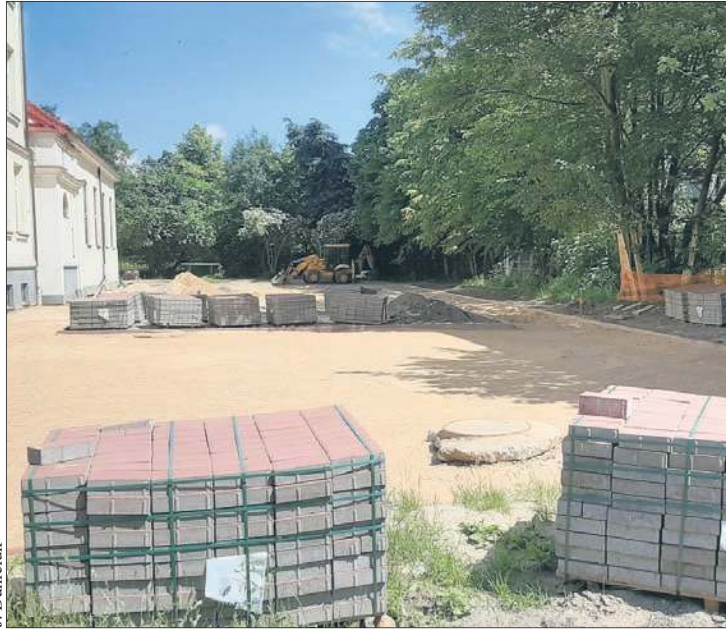
Trwa budowa placu zabaw przy Szkole Podstawowej nr 14 przy Al. Jachowicza 20
