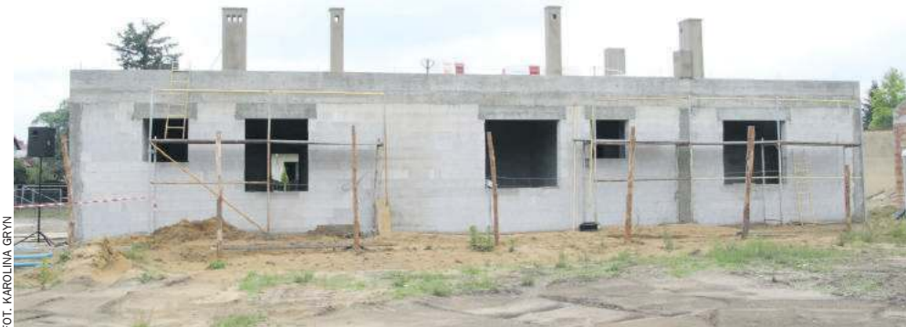
Zakończenie budowy komisariatu zaplanowano na sierpień 2024 roku
