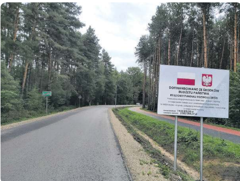
Przebudowana droga powiatowa Jata – Zalesie – Sójkowa
