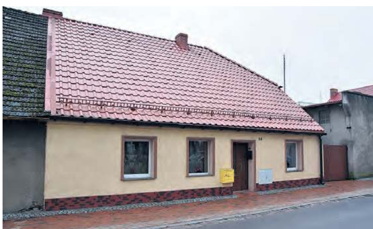
Na domu przy placu Zamkowym 11a wykonano m.in. remont elewacji.
