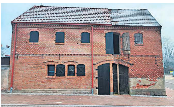
Część budynku przy ul. Sępoleńskiej 16 po modernizacji zmienia swoje przeznaczenie z obiektu gospodarczego na mieszkalny. Fot. UM Tuchola
