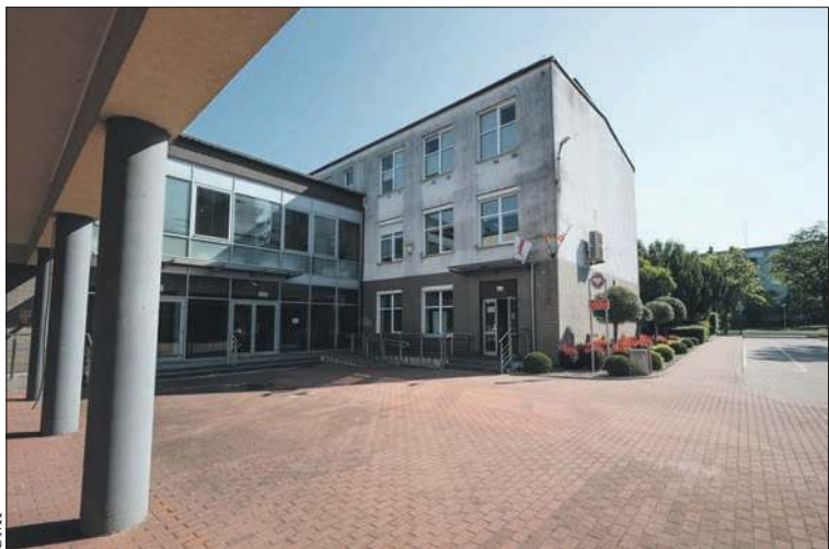
Budynki III LO przejdą modernizację
