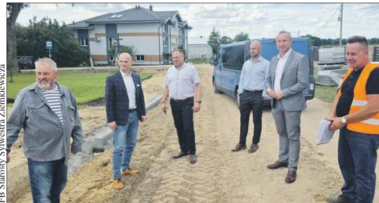
Na placu budowy odbyło się spotkanie robocze z udziałem przedstawicieli samorządów zaangażowanych w realizację zadania
