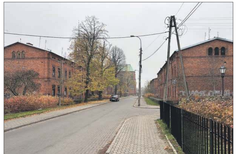
Domy na osiedlu robotniczym
