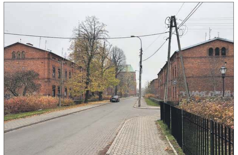
Domy na osiedlu robotniczym
