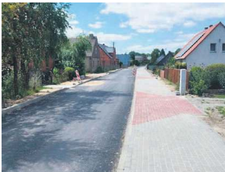
Warstwę asfaltową wykonano na ul. Słonecznej do przepustu. Na tej ulicy regulowano również studzienki. Fot. softys Suchej Damian Karczewski.
