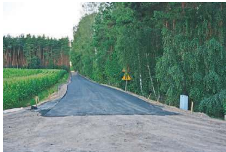
Na budowanej drodze wewnętrznej Welpin – Huta na etapie I wykonano warstwę wiążącą nawierzchni. Fot. Anna Lipska
