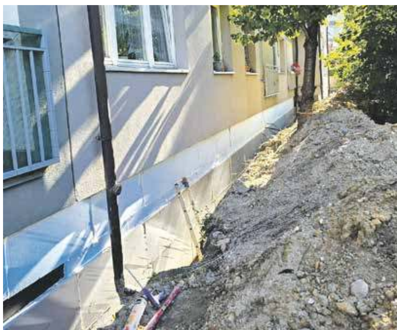
Izolowanie fundamentów to bardzo ważny element podczas renowacji budynku
