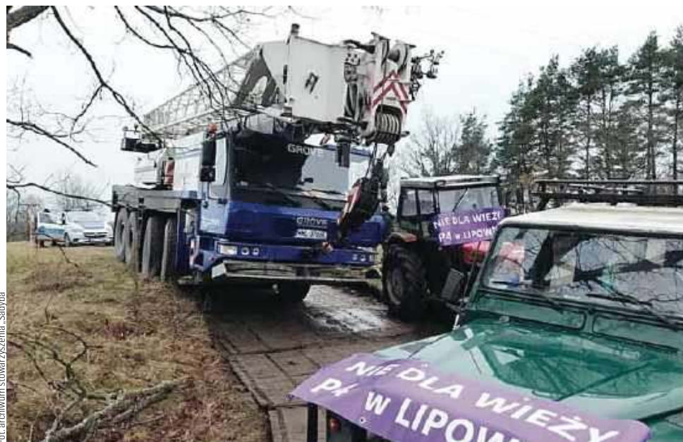
62-metrowy maszt miał stanąć już w połowie grudnia
