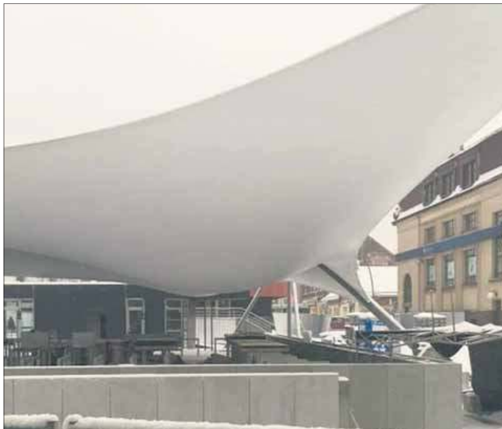
Wykonawca ma ponownie naprężyć płachtę
