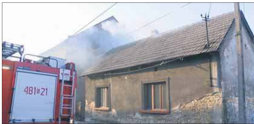
Powodem pożaru był nieczyszczony przewód kominowy
