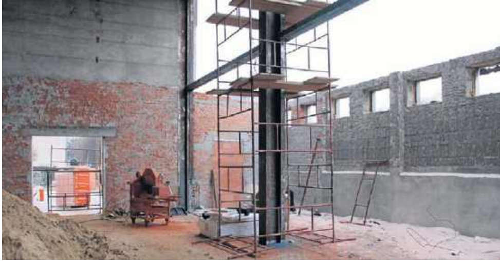
Trwa przebudowa dawnej pływalni przy ulicy Leszka Czarnego w Radomsku. Powstanie tu nowoczesna hala sportowa. Prace mają się zakończyć w 2027 roku
