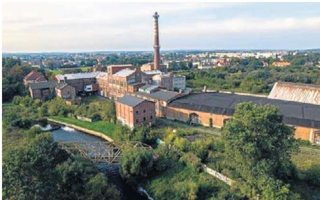
Pruszczańska Cukrownia powstała w 1881 r. Zachowało się wiele budynków fabrycznych
