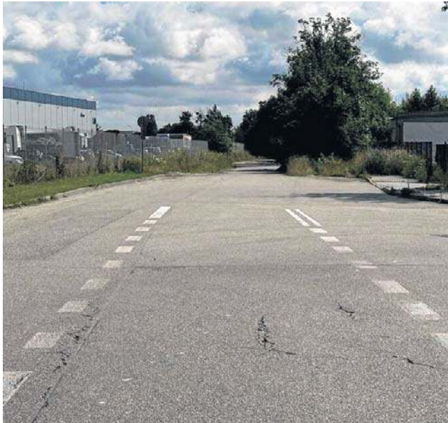
Budowa nowego układu komunikacyjnego ulicy Tczewskiej odciążą ruch na ulicy Zastawnej
