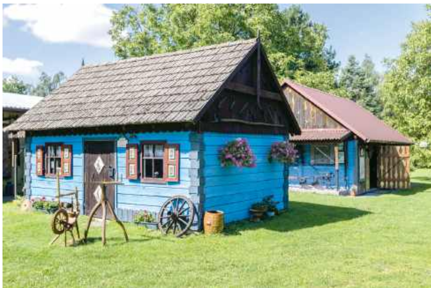
Na terenie galerii stoją charakterystyczne niebieskie chaty. Ściany pokrywano wapnem z dodatkiem barwnika, by m.in. odstraszać owady.
