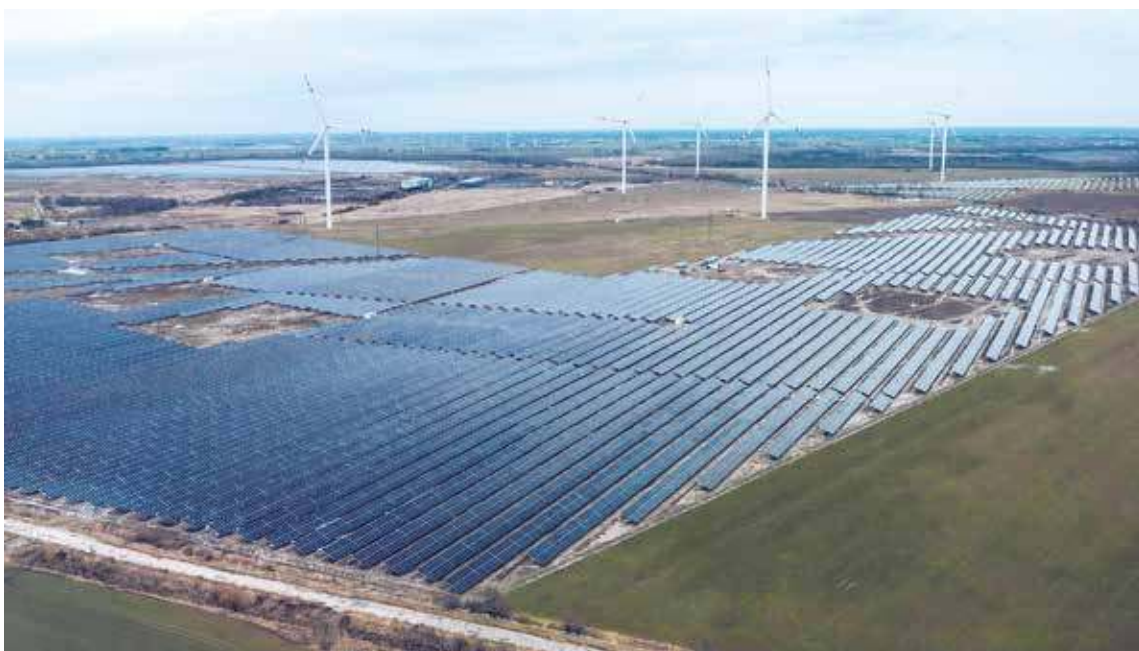
Enea kupiła od PAD RES farmę fotowoltaiczną o mocy 35 MW zlokalizowaną w Wielkopolsce
