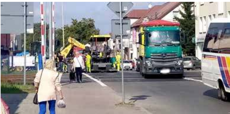
Prace na styku z ul. 700-lecia. Tu we wtorek widoczni byli pracownicy kierujący ruchem
