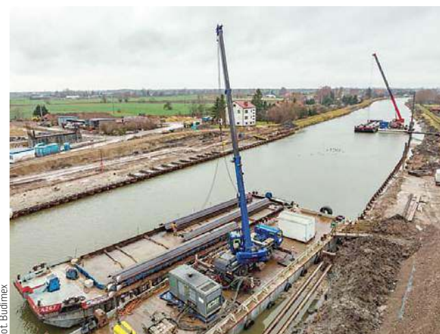
Jednocześnie trwają prace przy realizacji drugiego etapu
