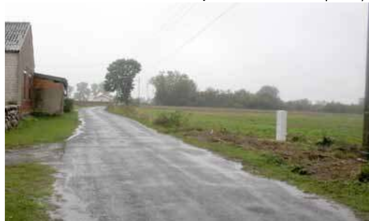
Maszt telefonii komórkowej powstanie tuż koło domów mieszkalnych w Wojcieszynie. Po prawej skrzynka elektryczna - to z niej będą zasilane nadajniki na maszcie
