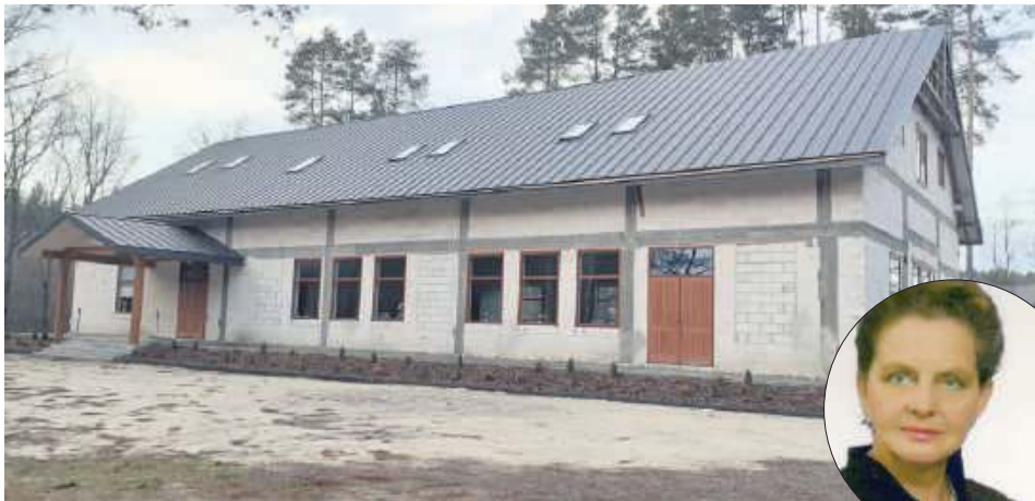
Maria Gmyz: W trakcie kontroli stwierdzono odstępstwa wykonanych robót od zatwierdzonej dokumentacji projektowej.
