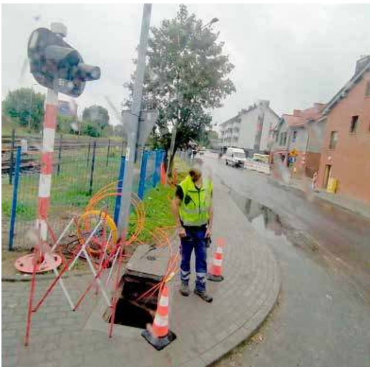
Prace prowadzone na terenie miasta przy ul. 700 Lecia. Foto. archiwum
