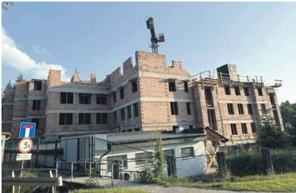
Prace przy odbudowie Szpitala Miejskiego przyspieszyły.
