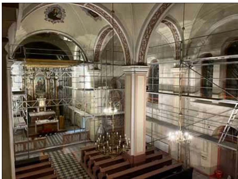
W świątyni rozstawiono rusztowania i wykonano już pierwsze prace renowacyjne.
