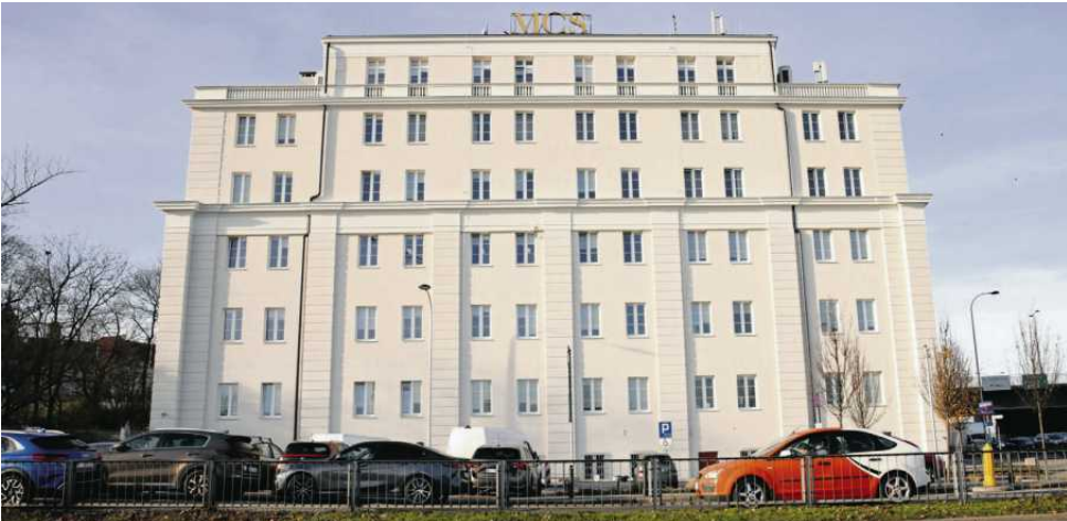
• Remont elewacji gmachu Mazowieckiego Centrum Stomatologii przy ul. Nowy Zjazd 1 wreszcie dobiega końca FOT. DAWID ZUCHOWICZ / AGENCJA WYBORCZA.PL
