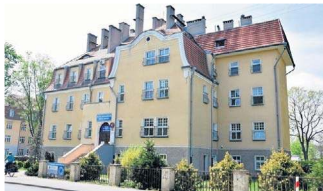
W pomieszczeniach po stacji dializ trwają prace adaptacyjne.
