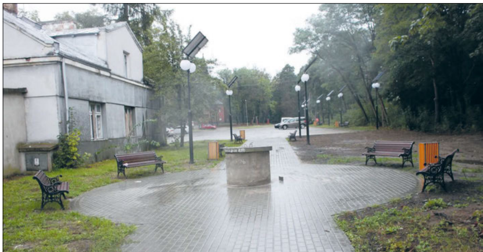
10 czerwca wójt podpisał umowę na realizację zadania inwestycyjnego związanego z rewitalizacją terenu przy byłej plebanii w Borkach
