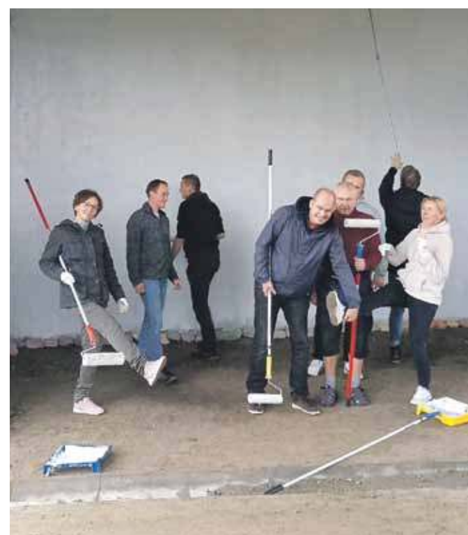
Najgorsza część prac już zrobiona. Ściana umyta z graffiti i wybielona, a teren wokół wysprzątany.
