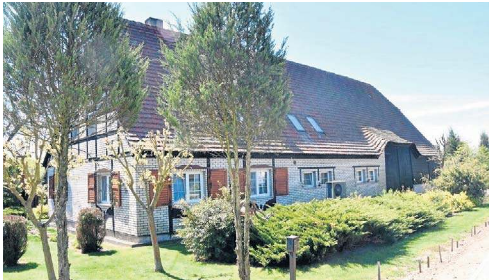
Charakterystyczna zabudowa została uznana za zabytkową
