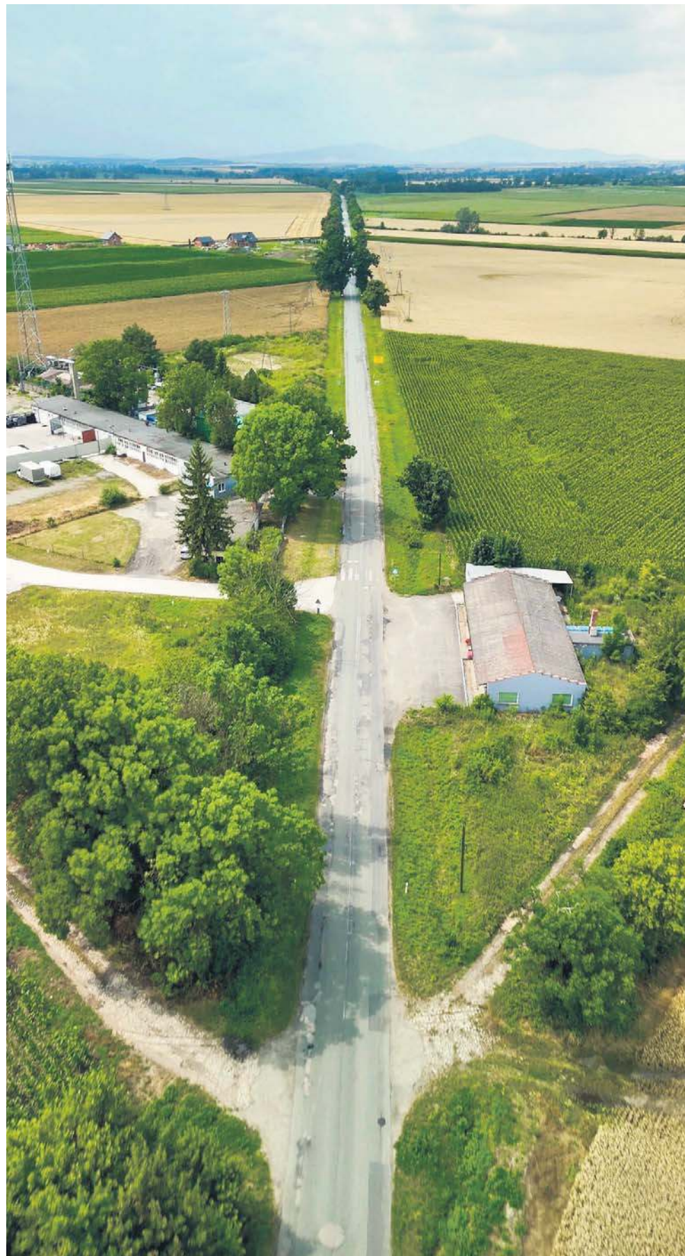
Już niedługo rusza modernizacja kolejnego odcinka DW346
