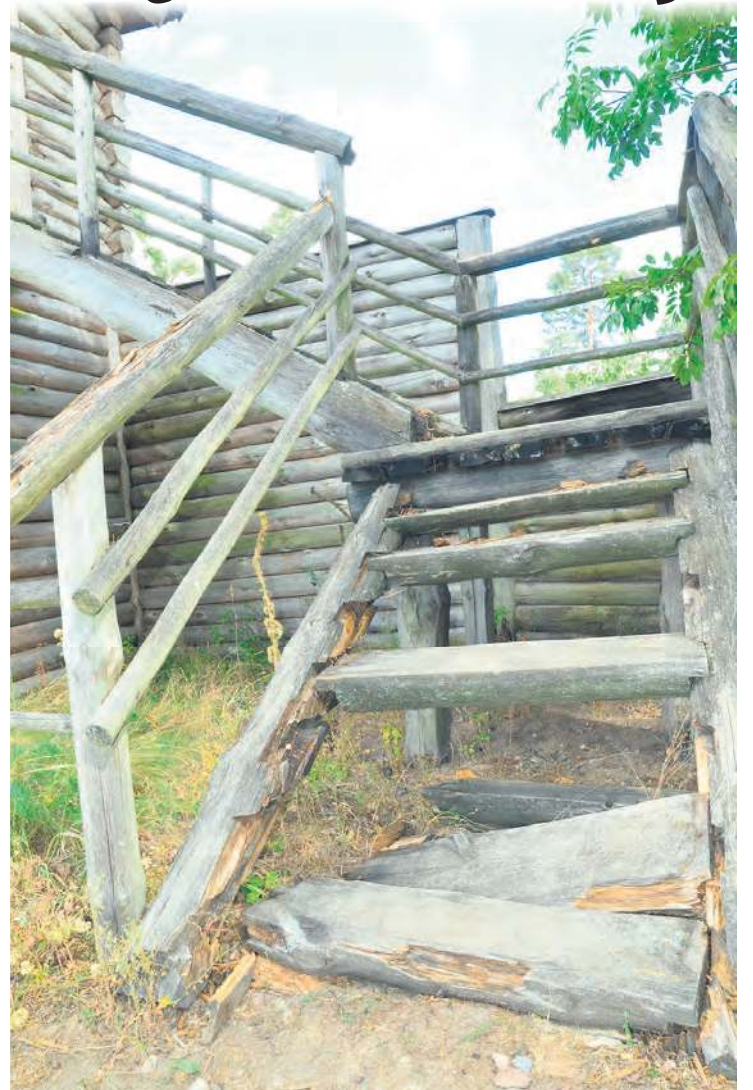
Schody prowadzące na wieżę – ekipę we wrześniu czeka sporo pracy.
