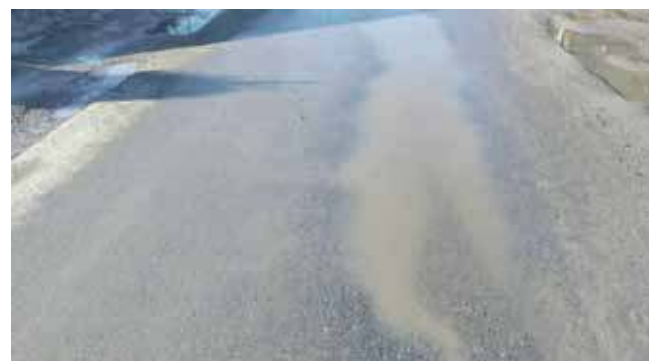
Ul. Partyzantów - w oczekiwaniu na ekipy remontowe.
